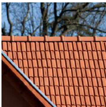
Țiglă ceramică profilată
