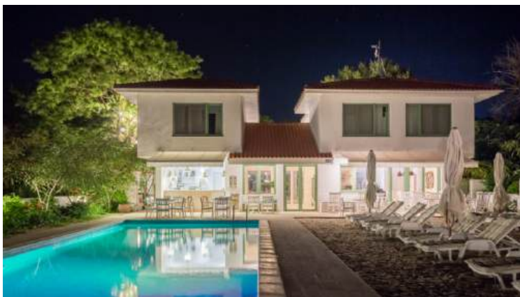
Acoperișuri simple în 2 și 4 ape ce urmează fidel conturul clădirii la fiecare nivel, cu streașină generoasă (Olimp)
