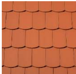
Țiglă ceramică/metalică tip solzi
