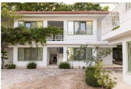
Tratare fațadă cu tencuială fină (Olimp)
