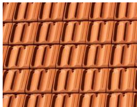
Țiglă ceramică profilată
