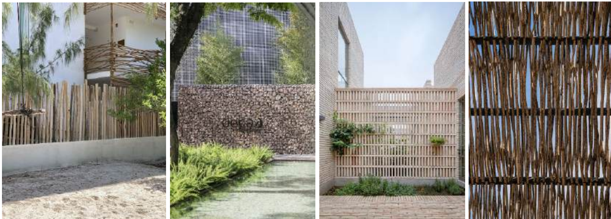
Exemple agreate de realizare a împrejmuirilor din materiale naturale: lemn natural, stuf / nuiele, cărămidă tradițională, piatră natural (surse diverse - ro.pinterest.com)
