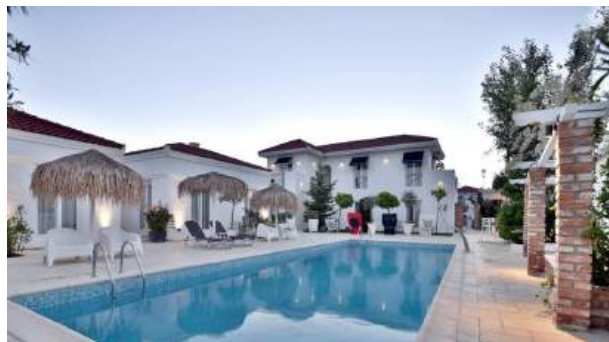
Acoperișuri simple în 4 ape ce urmează fidel conturul clădirii la fiecare nivel, cu și fără streășină (Vama Veche)
