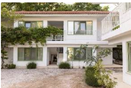
Tratare fațadă cu tencuială fină (Olimp)
