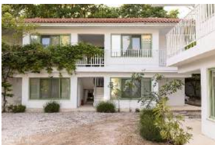
Tratare fațadă cu tencuială fină (Olimp)
