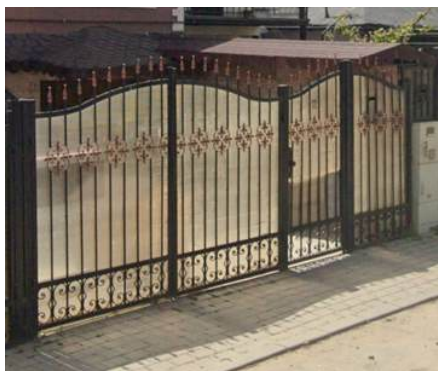
Împrejmuiri din fier forjat cu decorațiuni ne-specifice, dublate cu panou de policarbonat
