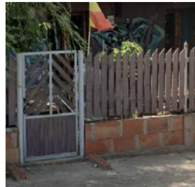
Împrejmuiri nefinisate din materiale nepotrivite pentru a rămâne aparente (blocuri ceramice cu goluri, BCA)
