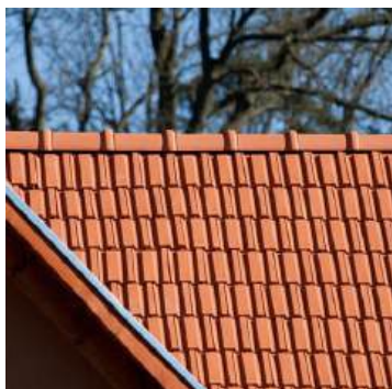
Țiglă ceramică profilată
