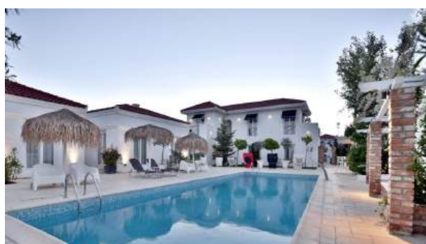
Acoperișuri simple în 4 ape ce urmează fidel conturul clădirii la fiecare nivel, cu și fără streșină (Vama Veche)
