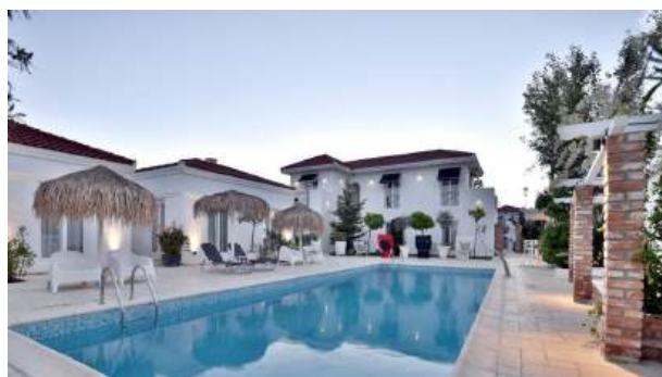
Acoperișuri simple în 4 ape ce urmează fidel conturul clădirii la fiecare nivel, cu și fără streășină (Vama Veche)
