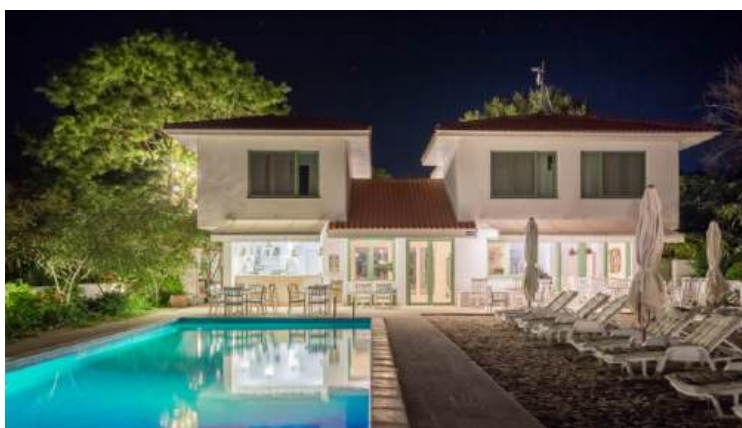
Acoperișuri simple în 2 și 4 ape ce urmează fidel conturul clădirii la fiecare nivel, cu streășină generoasă (Olimp)
