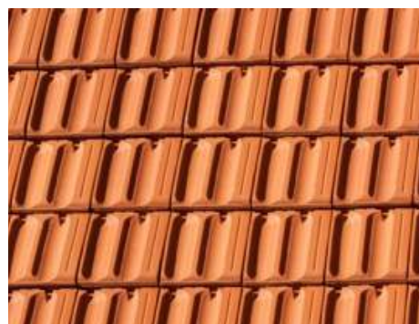
Țiglă ceramică profilată
