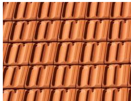
Țiglă ceramică profilată
