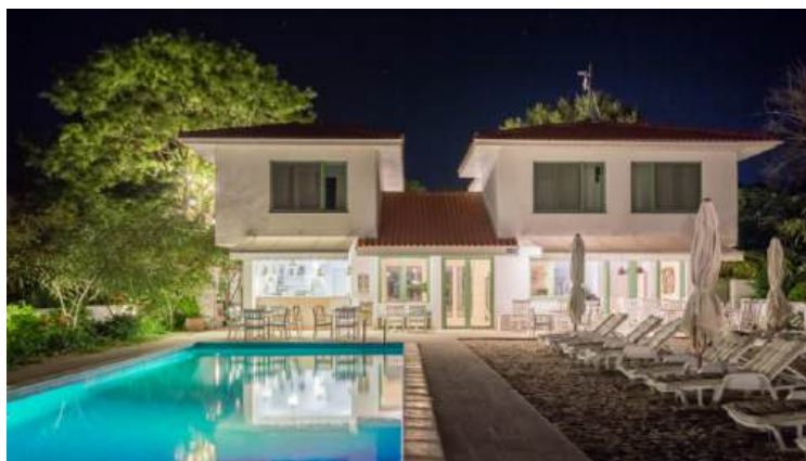
Acoperișuri simple în 2 și 4 ape ce urmează fidel conturul clădirii la fiecare nivel, cu streășină generoasă (Olimp)
