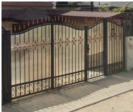
Împrejmuiri din fier forjat cu decorațiuni ne-specifice, dublate cu panou de policarbonat
