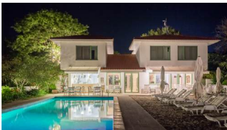
Acoperișuri simple în 2 și 4 ape ce urmează fidel conturul clădirii la fiecare nivel, cu streășină generoasă (Olimp)
