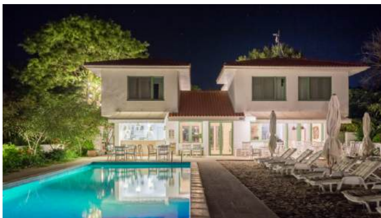
Acoperișuri simple în 2 și 4 ape ce urmează fidel conturul clădirii la fiecare nivel, cu streășină generoasă (Olimp)
