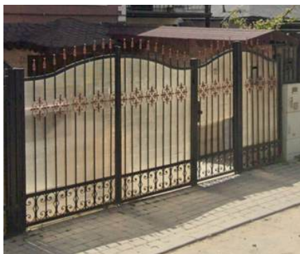
Împrejmuiri din fier forjat cu decorațiuni ne-specifice, dublate cu panou de policarbonat
