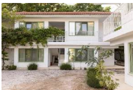
Tratare fațadă cu tencuială fină (Olimp)
