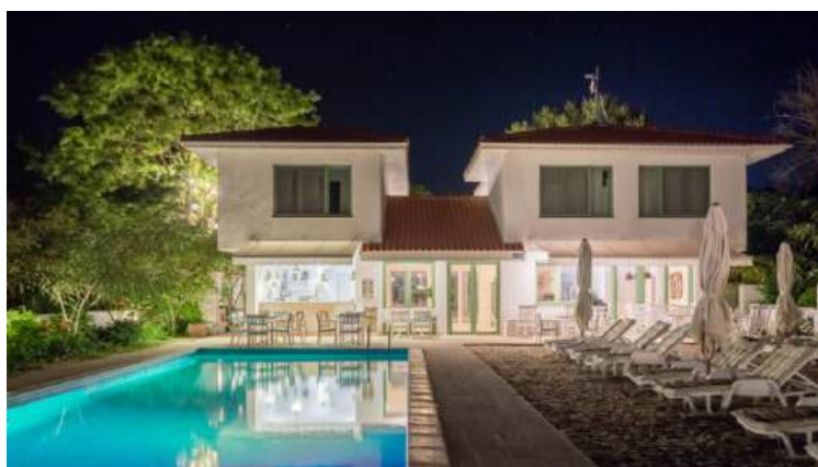
Acoperișuri simple în 2 și 4 ape ce urmează fidel conturul clădirii la fiecare nivel, cu streașină generoasă (Olimp)
