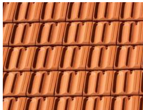
Țiglă ceramică profilată
