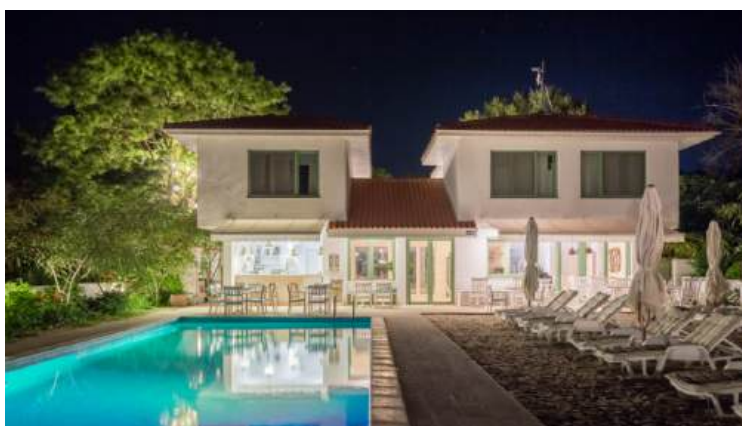
Acoperișuri simple în 2 și 4 ape ce urmează fidel conturul clădirii la fiecare nivel, cu streșină generoasă (Olimp)
