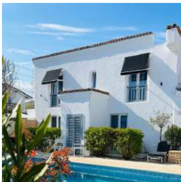
tâmplării în 2 canaturi cu obloane/ copertine mobile, gamă cromatică armonizată cu paramentul
